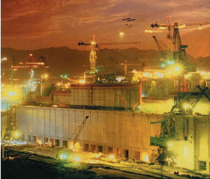
图 2-1 繁忙的建筑工地
