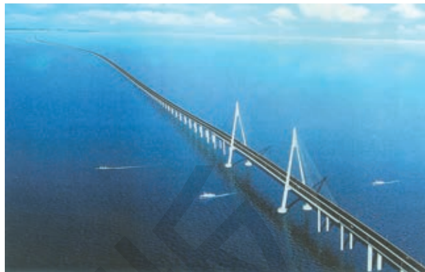
图 1-32 建造中的宁波跨海大桥
