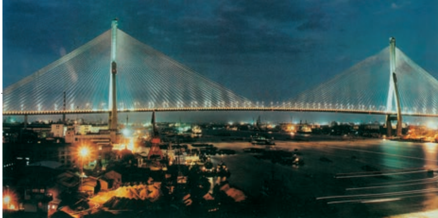
图 1-30 上海杨浦大桥
