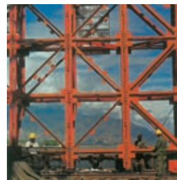
a 拉萨河特大桥局部构造
