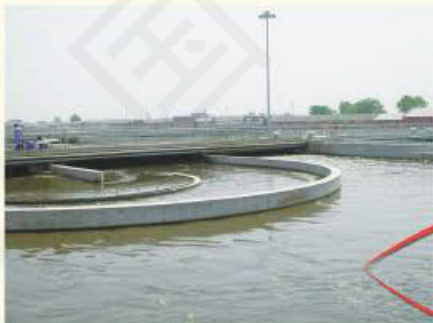
北京酒仙桥污水处理厂
