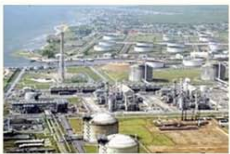
尼日利亚的石油园区
