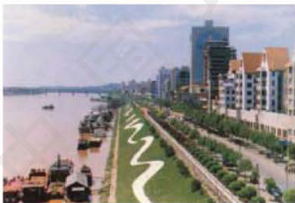
图3-1-4 城市防灾设施——长沙湘江防洪大堤
