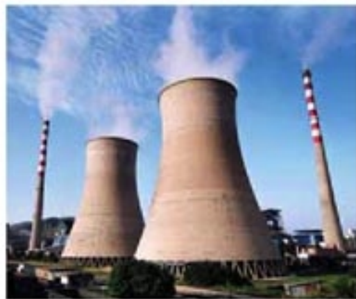
图 10.4-4 热电厂的冷凝器。烟筒似的器壁内有很多管道，来自蒸汽轮机的废气在管道内冷却。器壁的下沿与地面间留有缝隙，便于冷凝器内空气的流动，同时有冷水喷到管道上，增强冷凝效果。
