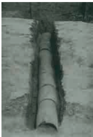
二号宫殿东廊下的 陶质排水管道
