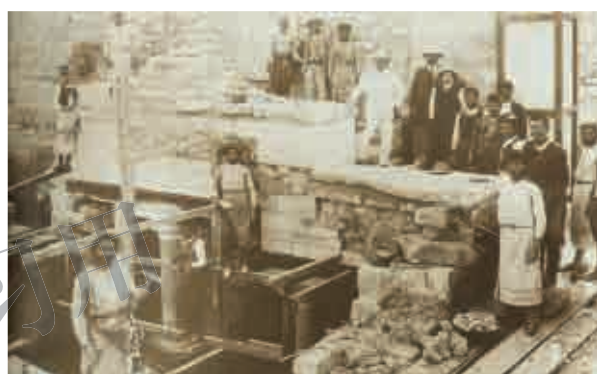
修复克诺索斯宫殿的现场
