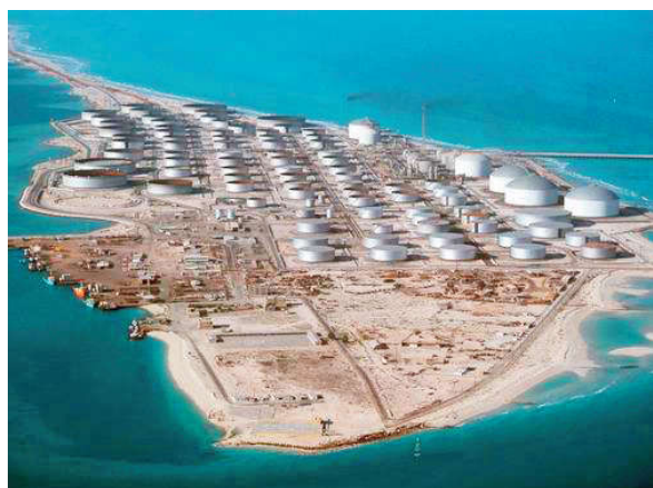
图 7-27 西亚石油储油设施
